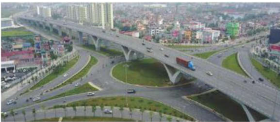
Hình 9.7. Cầu vượt thép tại nút giao Nguyễn Văn Cừ quận Long Biên, Hà Nội
